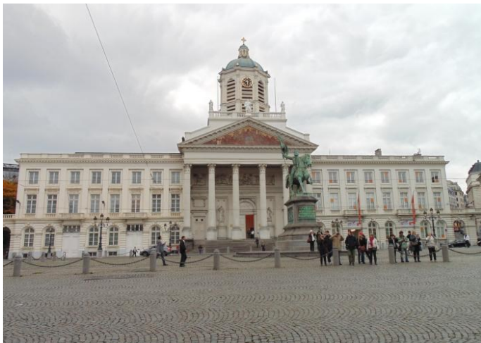
Grondwettelijk Hof te Brussel
